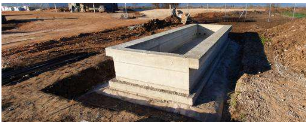
Εικόνα 6-2: Τυπική μορφή θεμελίωσης οικίσκου.
